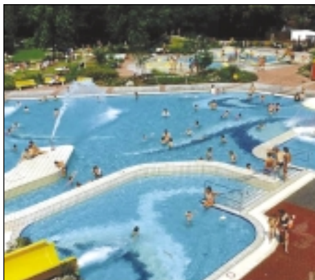
Abb. 10 Geothermisch beheiztes Schwimmbad in Straubing.
