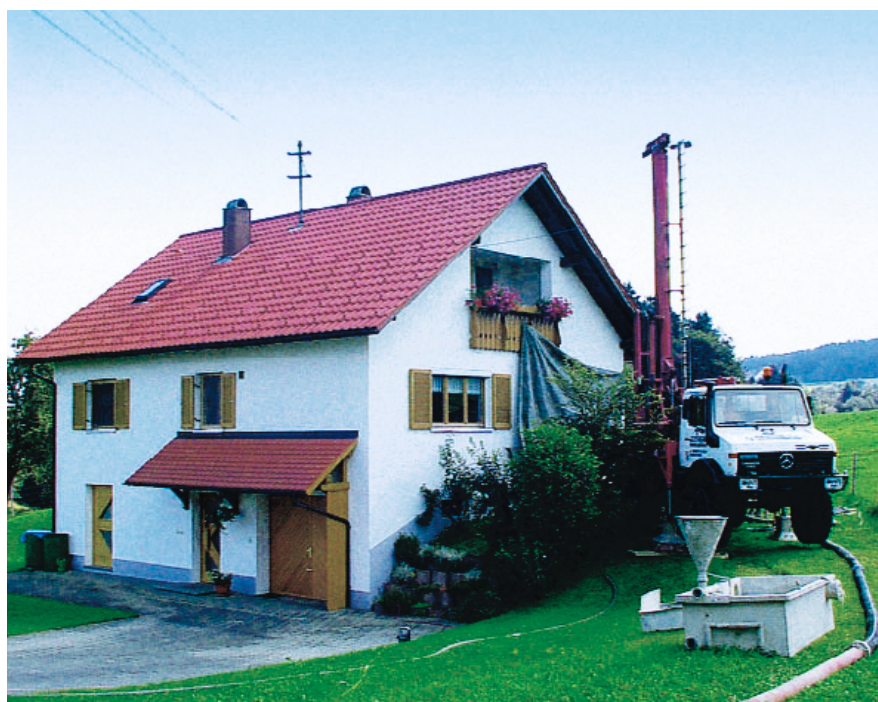
Bohrarbeiten für eine Erdwärmesonde an einem Einfamilienhaus.
