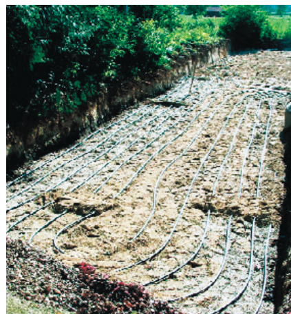
Einbau eines Kapillarrohrmatten-Erdwärmekollektors bei einem Neubauprojekt.
