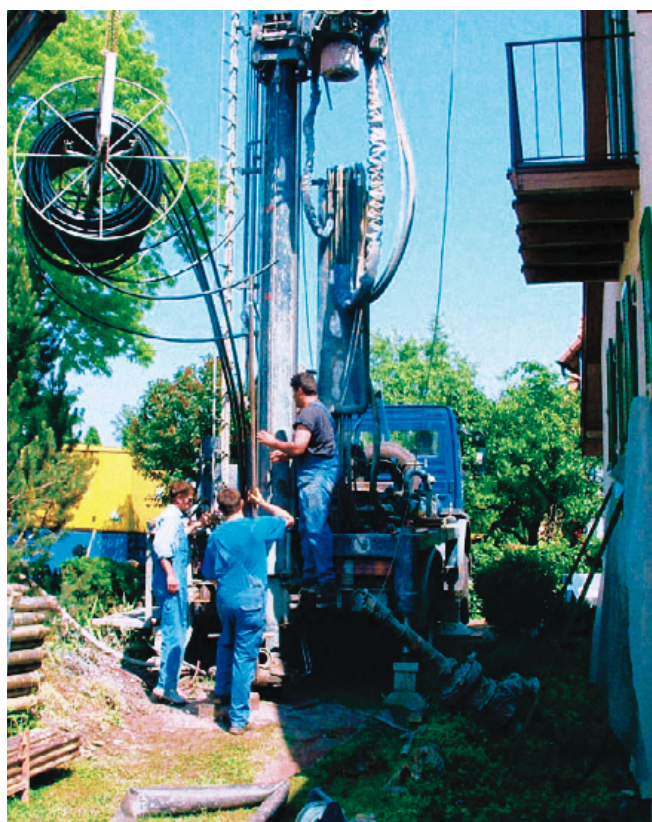
Bohrarbeiten für eine Erdwärmesonde an einem Einfamilienhaus.
