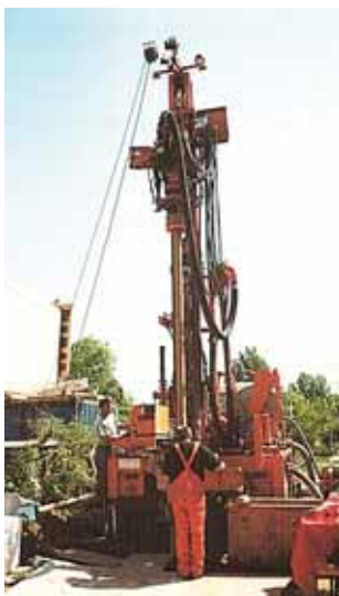
Bohrarbeiten für die Erdwärmesonden
