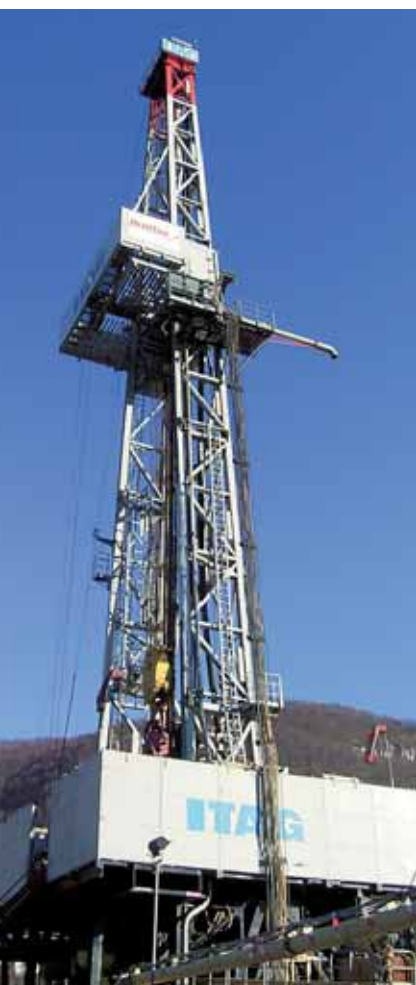
Bohranlage Bad Urach
