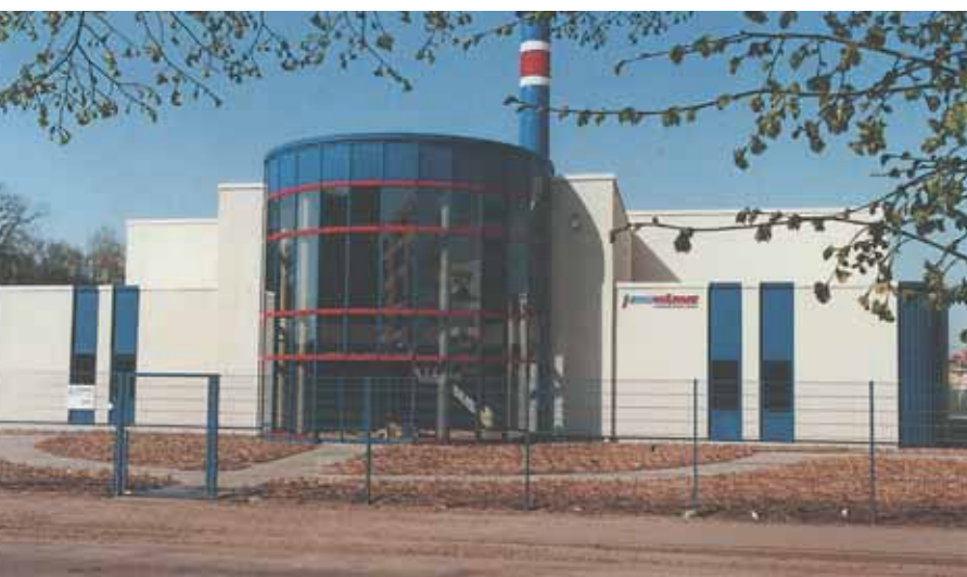
Ein erster Schritt in Neustadt-Glewe: Das „kalte“ Kraftwerk
